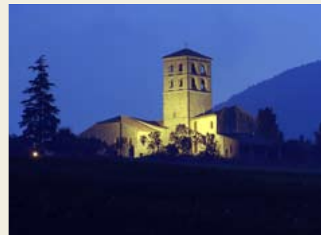
Chiesa di Bardone
